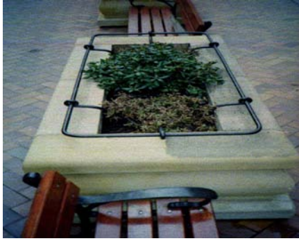
Odgrzybianie i oczyszczenie piaskowca / Chojnice /
