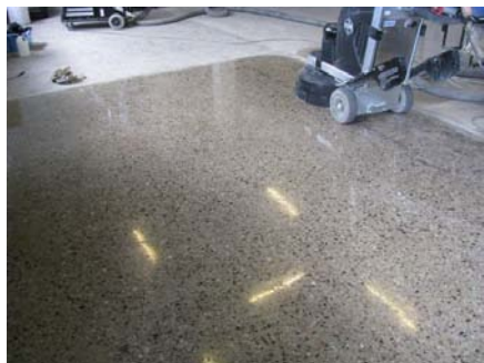
polerowanie betonu
