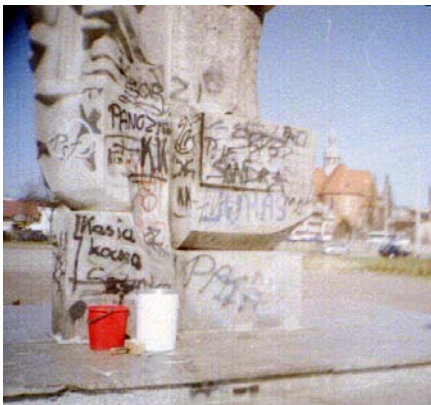
Usuwanie graffiti, oczyszczenie i zabezpieczenie przed graffiti pomnika w Kościerzynie
