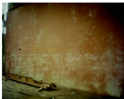
Oczyszczenie cegły licówki z wykwitów wapiennych i impregnacja hydrofobowa / Most w Gdyni /
