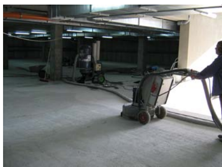
szlifowanie betonu
